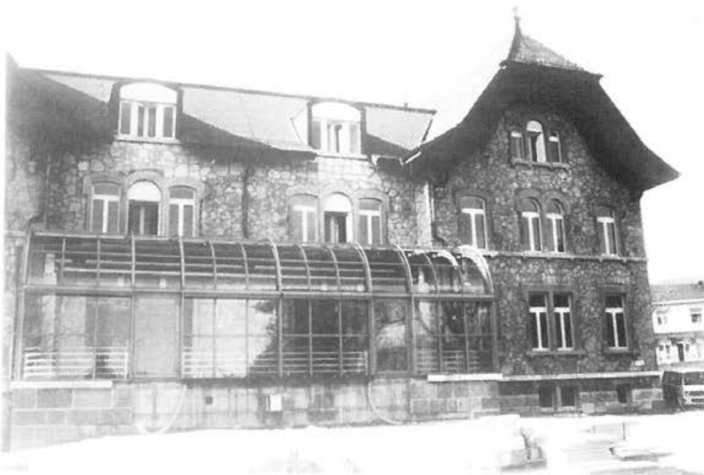
Photo 2 : Pavillon Pernod après transformation. On notera l'ancienne couverture conservée sur l'aile droite du bâtiment.
