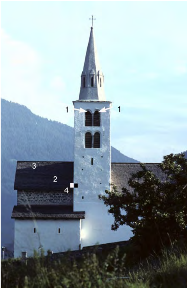
Fig. 4: L'église St-Sylve après la rénovation (vue du nord). 1. Entrées pour les rhinolophes. 2. Combles du chœur. 3. Nouvel emplacement principal de la colonie de grands rhinolophes dans la sous-pente. 4. Nouveau tunnel d'accès entre clocher et combles. (Photo Raphaël Arlettaz)
