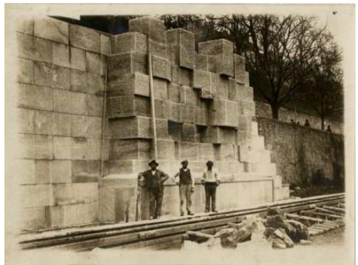
Ouvriers devant la maçonnerie des blocs du groupe central avant sculpture Photographie Acm-EPFL 0002.01.0028 © Acm-EPFL
