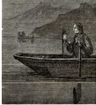
La mesure de la vitesse du son dans l'eau: le bateau émetteur et le bateau récepteur Amédée Guillemin. Le son, notions d'acoustique physique et musicale . Hachette, Paris, 1878 Bibliothèque du Musée d'histoire des sciences
